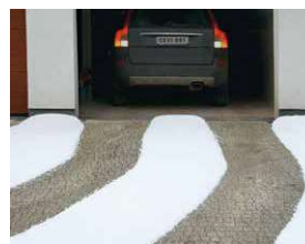
Nyomsáv fűtés térkő burkolatban
